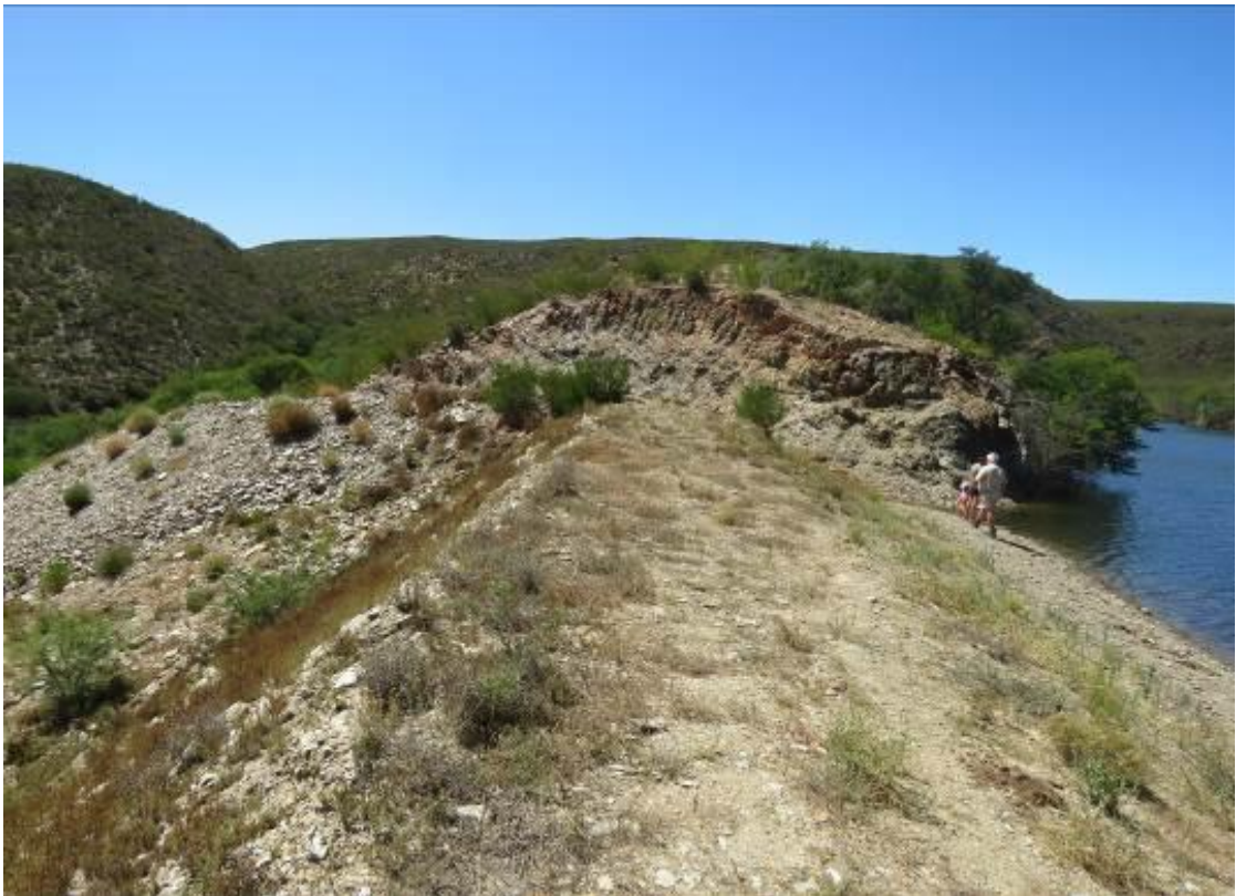
Foto 4: Uitsig oor die uitbreiding van die nuwe damwal en die herbelyning van die oorloop binne 'n waterloop op Plaas Buffelsrivier 42/46.
